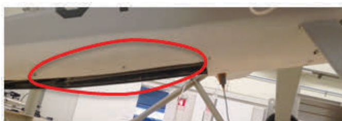
Figura 6 – Local de instalação da câmara
