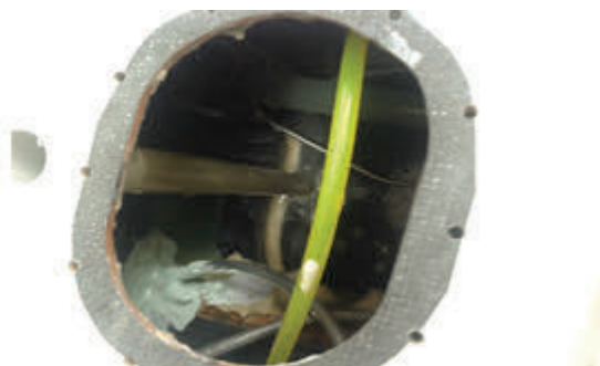
Figura 7 – Interior do depósito de combustível
